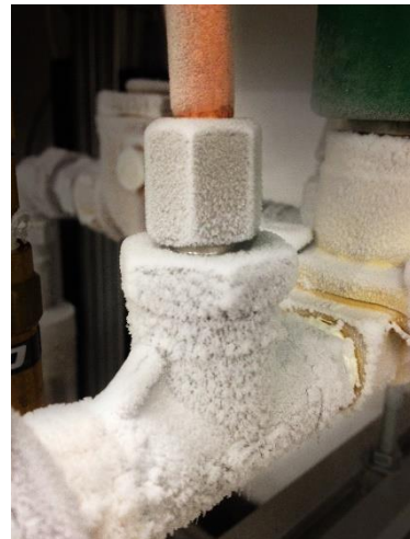
Abb.2 Vereiste_Verschraubung
